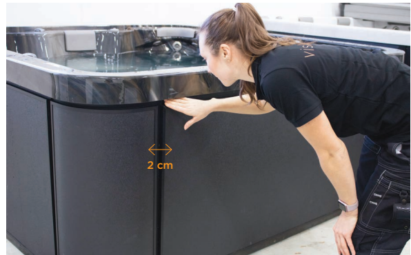
3. Liikuta paneelia sivuttaissuunnassa niin, että paneelin vasemmalla ja oikealla puolella on n. 2 cm rako.
