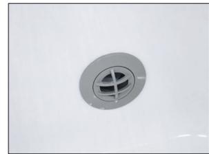
**4. Jets de circulation** - L'eau ressort ici dans le spa jacuzzi après avoir été aspirée à travers les filtres, la pompe de circulation, le réchauffeur et le circuit AOP. Cette eau peut être légèrement plus chaude que le reste de l'eau du spa si le réchauffeur est en service.
